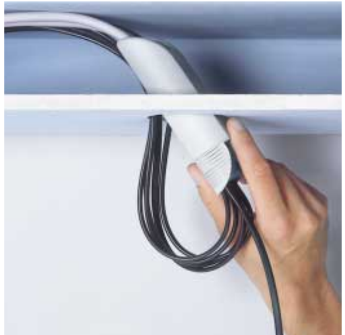
Die verdrahtete 150 W-Mouse wird mit der Primärseite voran in die Deckenöffnung eingeschoben.
